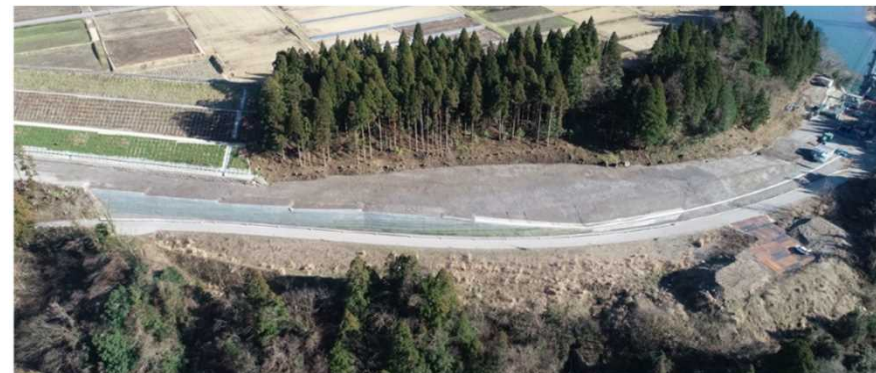
当該現場全景(完成状況)
