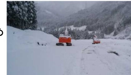
2017年2月の施工箇所の積雪状況
