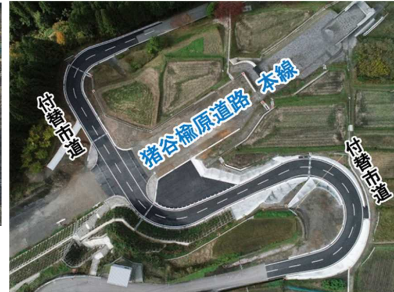
市道付替箇所全景(完成状況)
