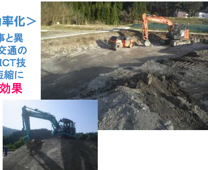
市道付替工施工状況
